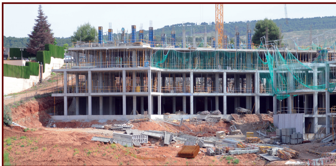
Imagen general del estado de las obras de la nueva residencia para mayores Beato Leopoldo de Alpanseire.
