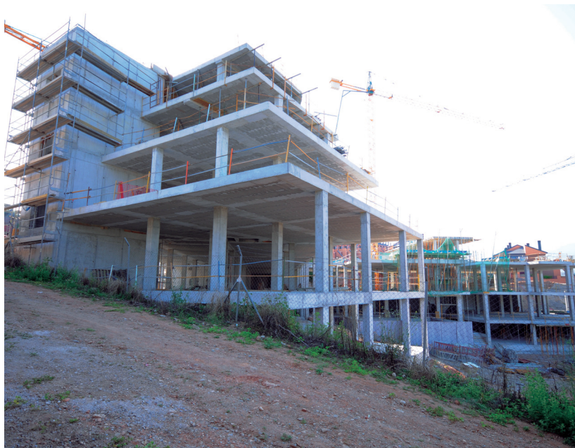
La primera fase de la construcción ha finalizado cumpliendo los plazos.
